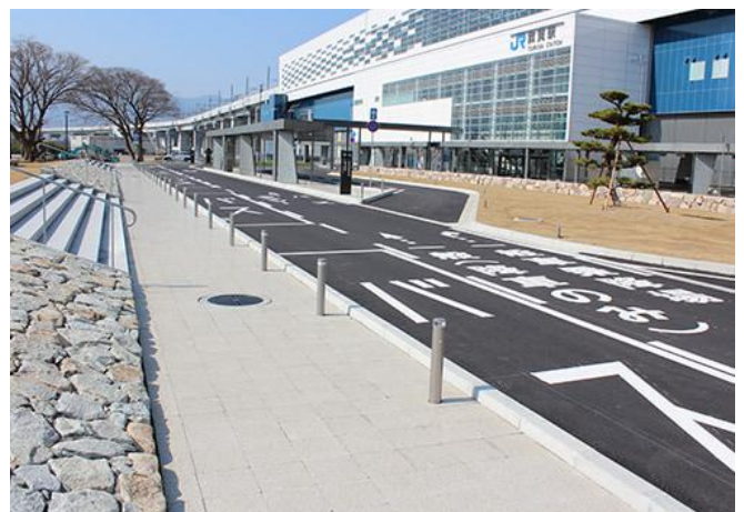
敦賀市新幹線駅前広場整備工事
