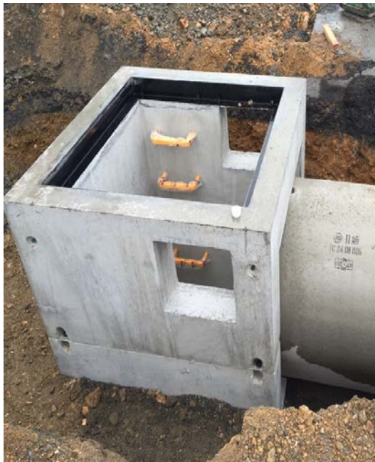
上下設置状況
