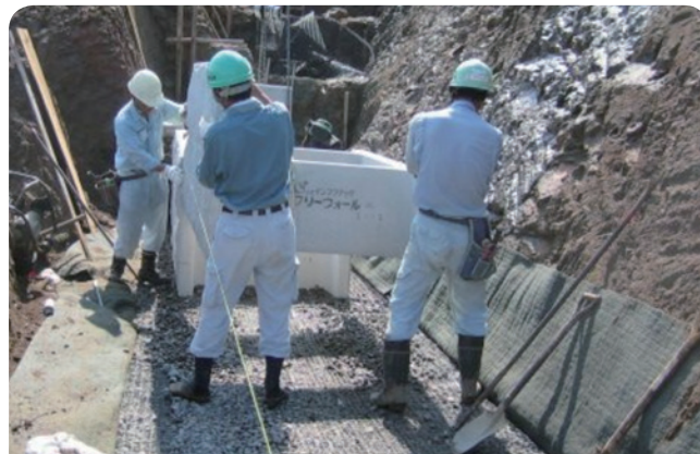
1段目施工開始(据付)
