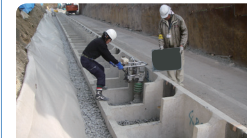
充填材 1層目転圧
