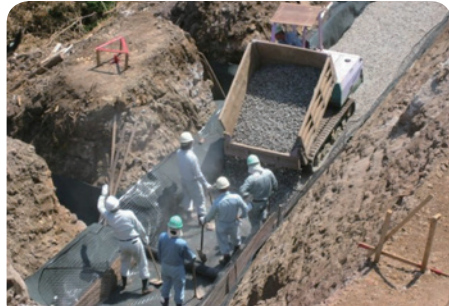
テンサー基礎工(単粒度碎石投入)
