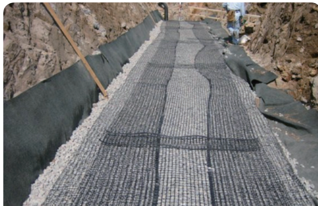
基礎かごテンサー(完成状況)
