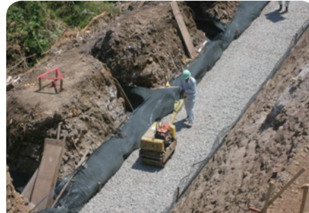
テンサー基礎工(転圧締固め)
