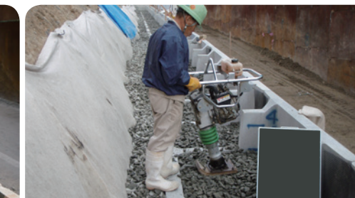
充填材 2層目転圧
