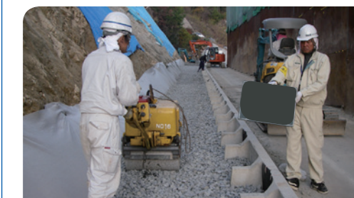
充填材 3層目転圧
